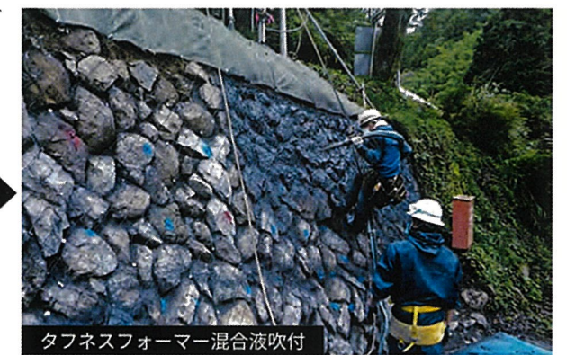
タフネスフォーマー混合液吹付
