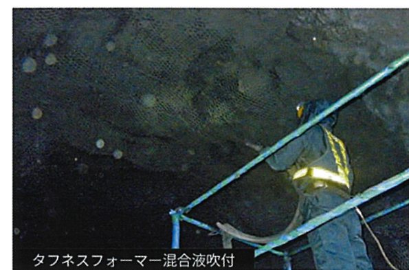
タフネスフォーマー混合液吹付
