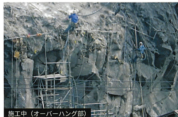
施工中（オーバーハング部）
